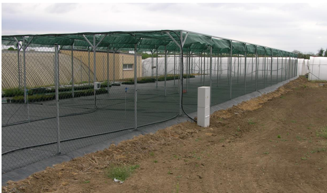
Obr. 44 Pohled na zastíněnou část kontejnerovny
